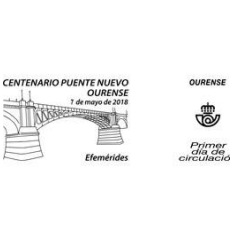
Efemérides. Centenario Puente nuevo Ourense
